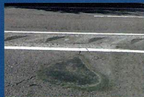
穴ぼこを補修し、安全を確保！
